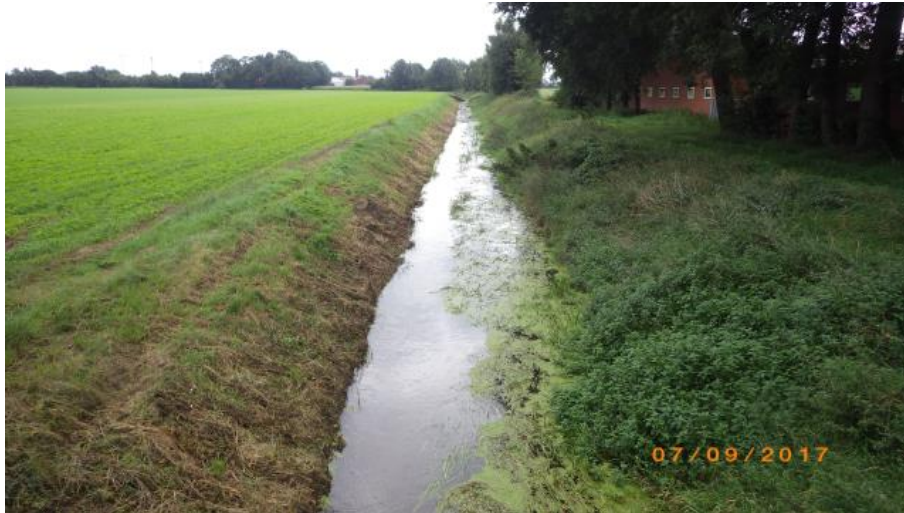
Abb. 6: Untersuchungsstrecke Fische und Makrozoobenthos mit linkseitiger Unterhaltung an Böschung und im Profil
