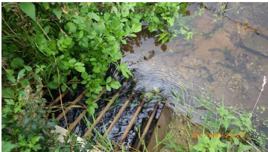
Abb. 5: Wasserentnahme oberhalb des Kulturstaus innerhalb der Untersuchungsstrecke Fische
